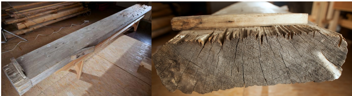
Fig. 1: Høvelbenken (venstre) og endeveden på venstre enden av benken (høyre). Foto R. Renmælmo.
